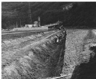
左：1区試掘(北) 右：1区南端試掘(北)
