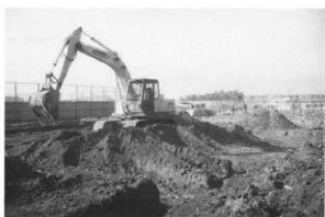
重機による作業
