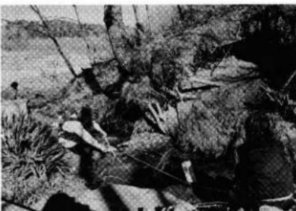
「西出構先で流水量、川の形状を測定している所」
