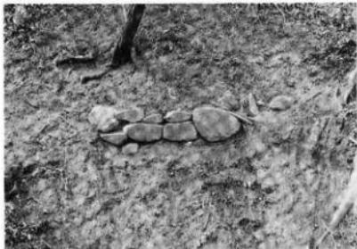
写真55 主郭部大手土橋北側土塁法面石積
