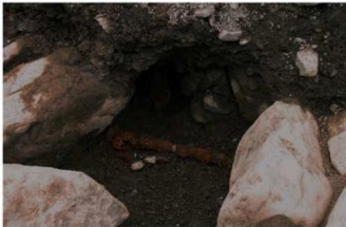
第1 レンチ木工沈床ボルトと丸銅（b列ボルト3）
