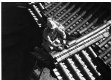
稻荷櫓門破損瓦葺き替え工事
