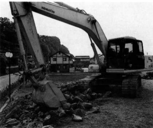
5 重機による堤体掘削
