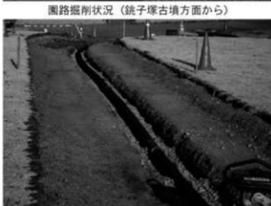
暗渠管布設状況（鏡子塚古墳方向から）
