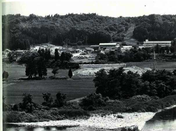
遺跡近景 (北から)
