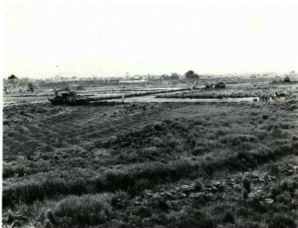
重機稼働状況 (西から)
