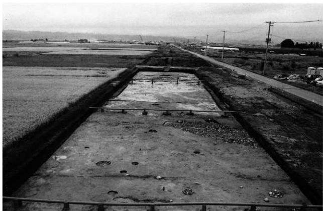
完掘状況 (C～E区)
