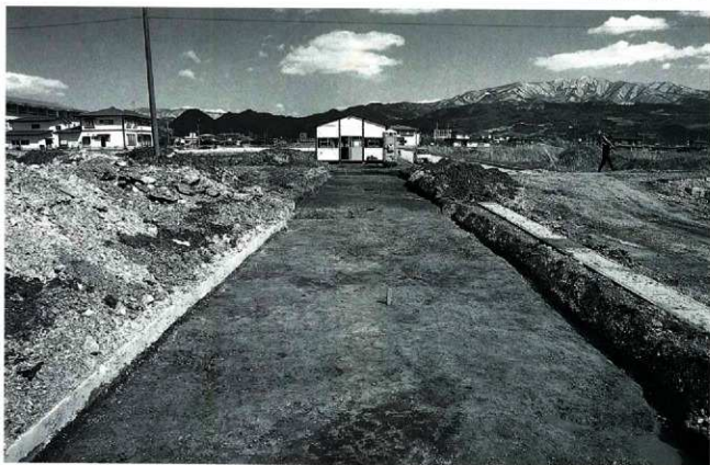
E区完掘状況（西から）
