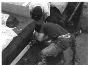
写真4 底部に木枠を組む
