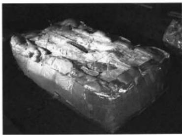
写真 17 側面へのウレタンの充填
