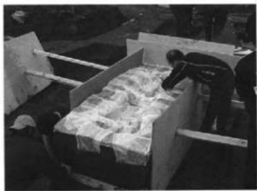
写真5 キムタオルによる表面の養生
