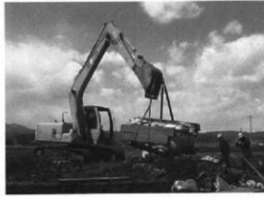
写真 19 バックホーによる遺構からの切り離し
