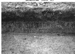
北東壁断面①（南から）
