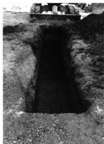
トレンチ全景 (東から)
