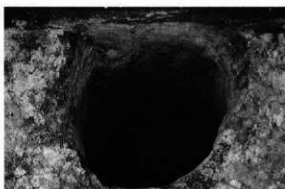
25号ピット全景 (北より)
