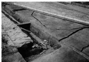
B1-3・4・5・6号溝(南東より)
