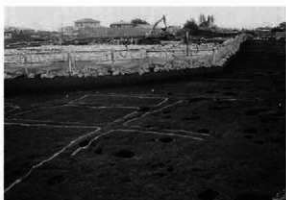
3区A s-C復旧水田 (東より)
