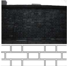
第22図 旧甲府税務署の煉瓦壁(フランス積み)
