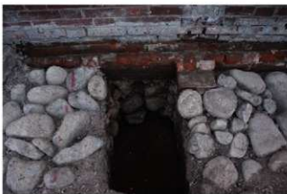
8. 調査区外西側煉瓦壁 基礎状況 東から
