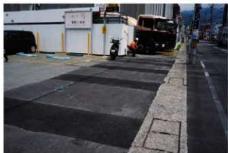
着手前の調査地点全景 南東より
