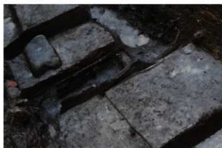
SD1 木枠検出状況 北東より
