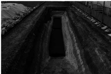
(1) 第1トレンチ全景(西から)
