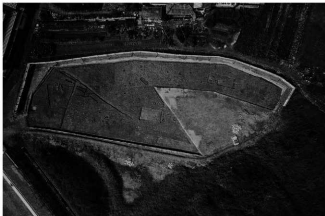
(1) 1区全景(上が北西)
