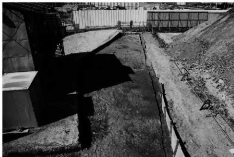
(1) c3-2地区第2遺構面北部全景 (南東から)
