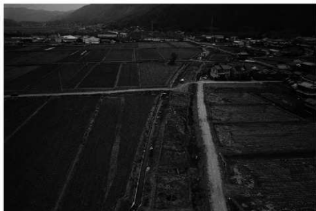
(1) I地区全景(南から)
