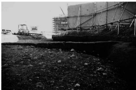
(2) c3-2地区 S D36断面(北西から)
