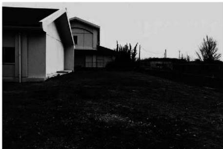
(3) Bトレンチ埋め戻し終了 (北から)
