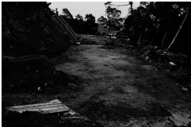
(1) 郭1-3 全景(北から)
