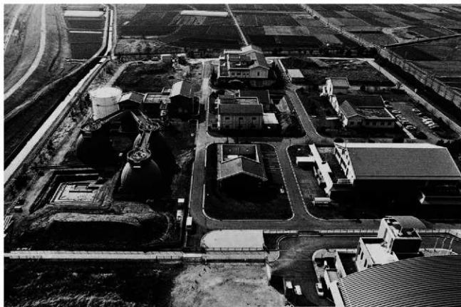
(1)調査地遠景(北から)
