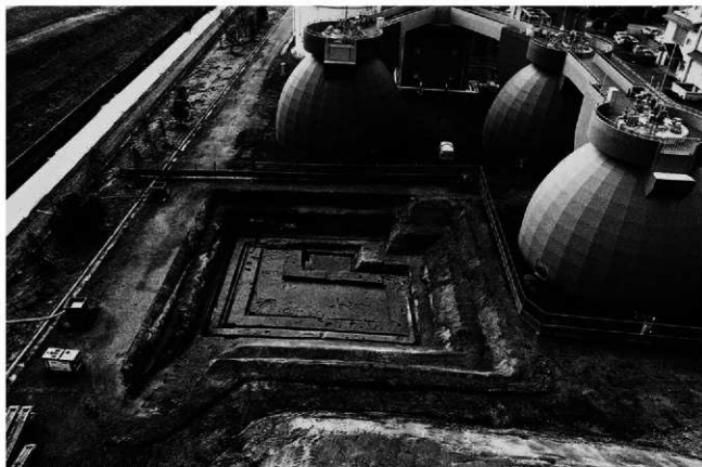
(1) Aトレンチ遠景(北から)
