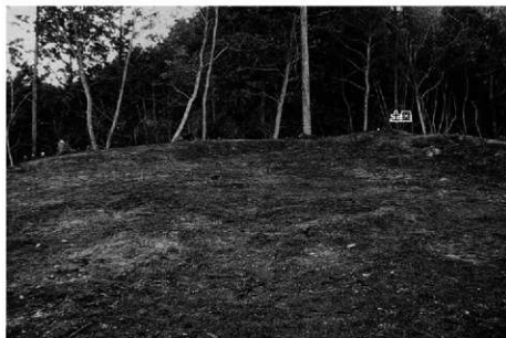
(1) A地区曲輪掘削前(北から)
