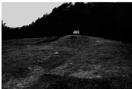
(3) A地区曲輪掘削完了状況 (北から)
