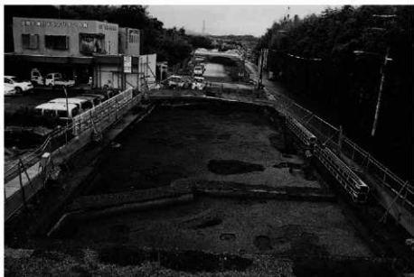
(1) 2 トレンチ北半部全景(南から)
