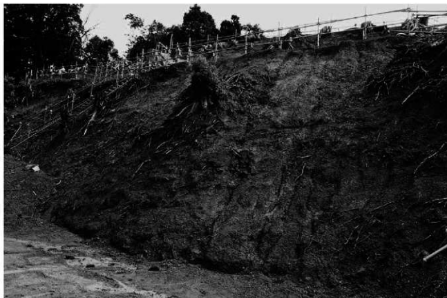
(2) 切岸2南部(南西から)
