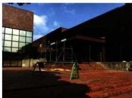
改修工事中の埋蔵文化財センター 外観
