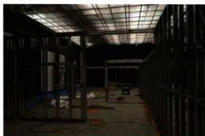
改修工事中の展示室
