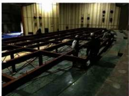
改修工事中の整理収納棟(旧芸館ホール棟)
