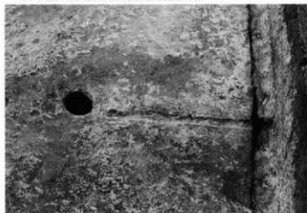
d. 柱穴 (P3号) に接する根太材を埋填した溝状の痕跡
