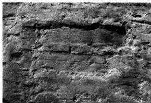
3 同上 復旧痕 鋤跡
