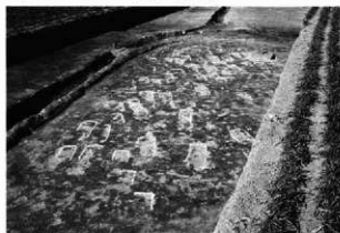
4 取付道C区245-678グリッド付近 As-A復旧前確認状態(南東から)
