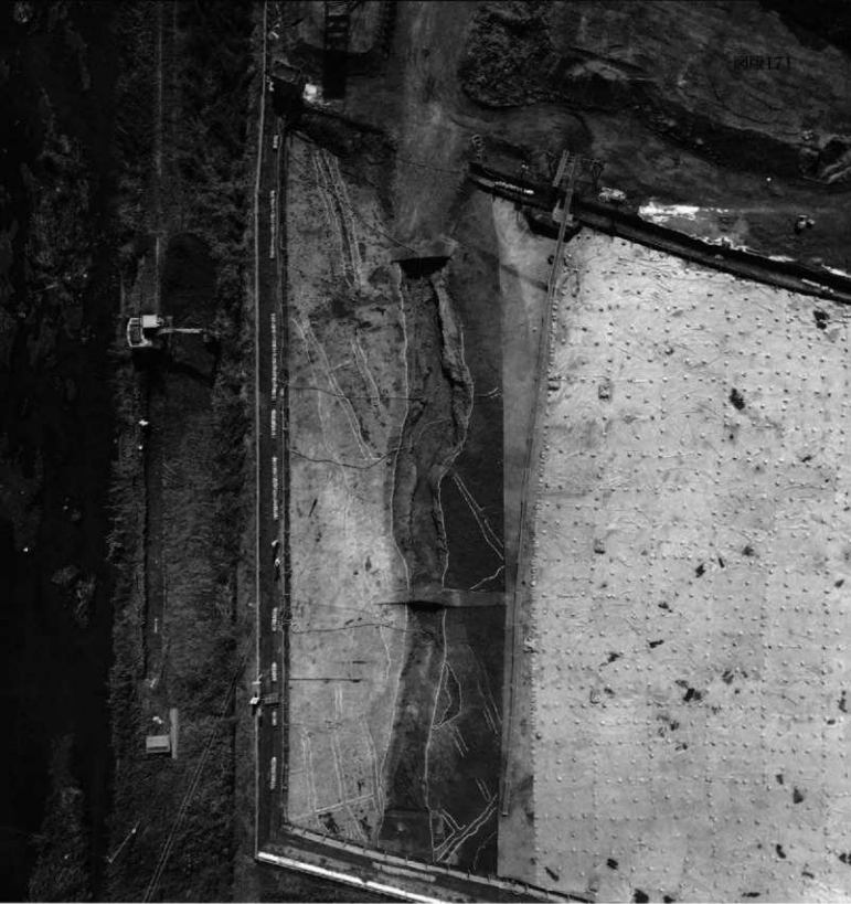
E区3面 東20m 全景1 As-C 混土水田底面・15溝 北上空から
