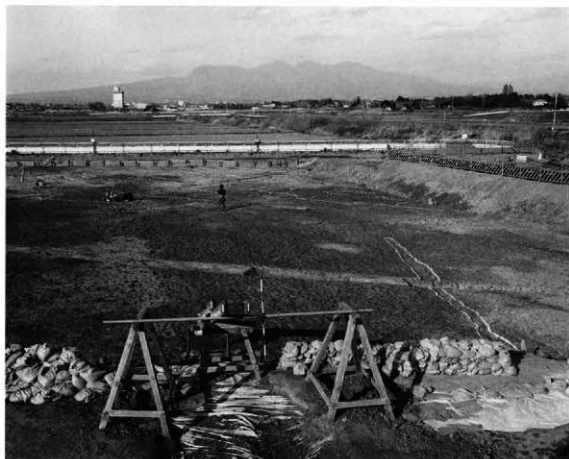
▲E区3面 西60m 全景2 As-C混土水田底面 南から
