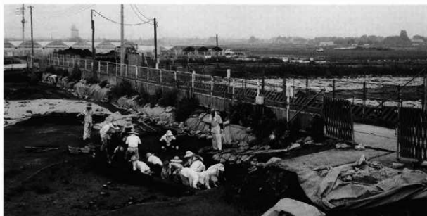
B1区2-3面 作業風景
