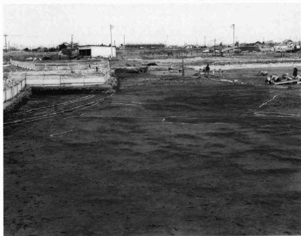
▼ D2区1面 As-B下水田 全景3 東から
