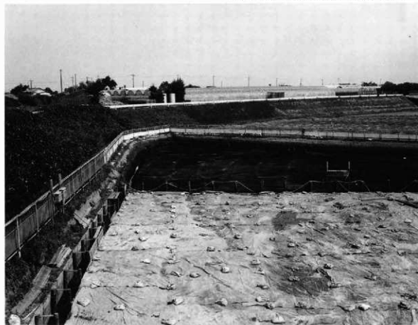
▼13区2面 As-C混土水田 全景7 西から
