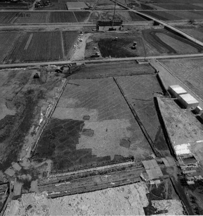
D区3面 西60m As-C混土水田底面1 西上空から
