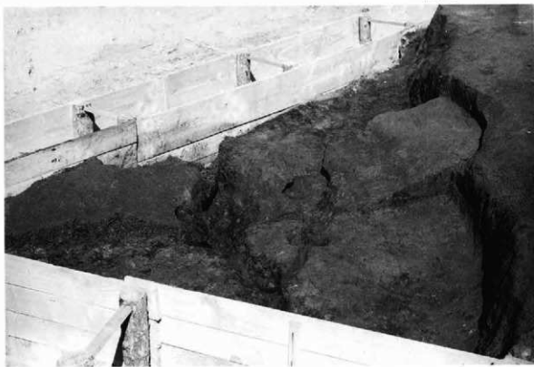
▼H1区1面 15溝 西から
