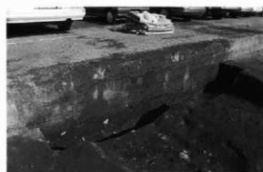
5. B2区1面 4号溝土層断面(南から)
