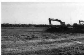
4. 重機による表土掘削作業風景（西から）
