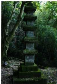
⑦田原家五重塔(杵築市)
