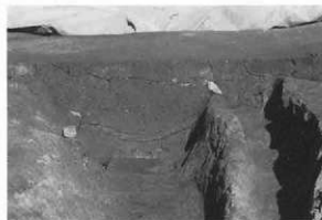
3-1-12・28・29・36号溝セクション01-00092-21
