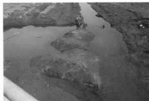
3-1-2号溝・池満水状況（南より）04-00018-02
