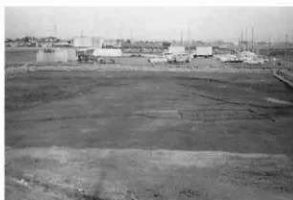
2-2-中部全景 (西より) 04-00069-08
