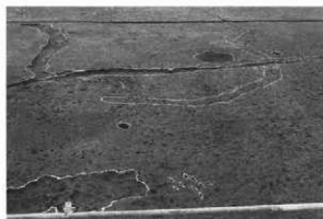
2-1-As-B下水田水田面中部南 (南より) 04-00048-01
