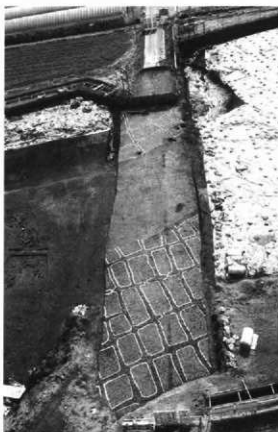
現道下調査区全景(北から)
