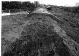
堤防下面（西から）
