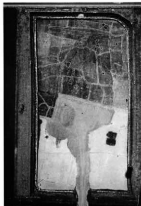
西半部全景 (上が西)
