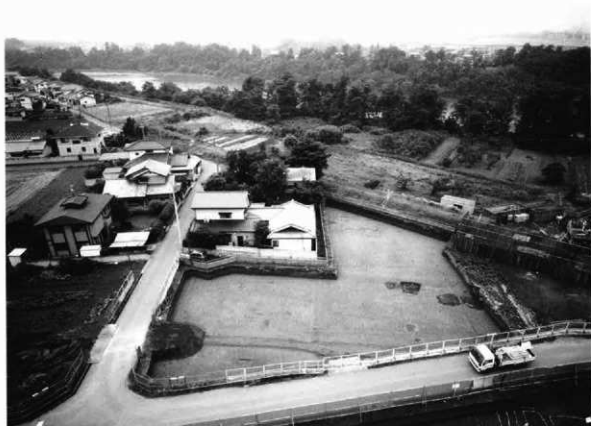
全景 (後方は利根川、北から)
