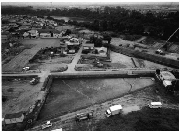
C区全景（後方は利根川、北から）
