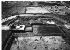
現道下全景(東から)
