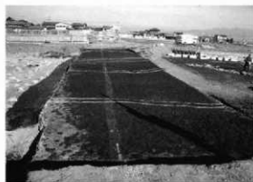
現調査(南から)
