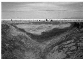
E区2号溝セクション（南から）〈5〉
