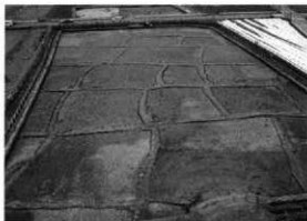
確認状況(東から)
