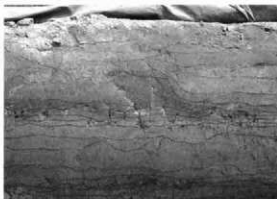
北壁 (第5面大柱畔付近、南から)
