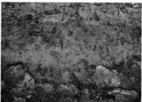
北壁(Hr-FA、Hr-FP、北東から)
