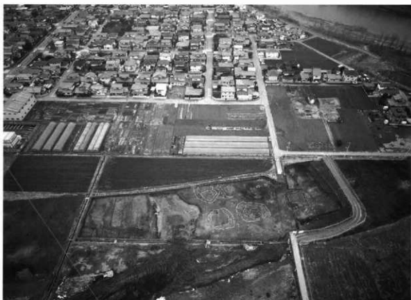
1号流路と現利根川(北から)
