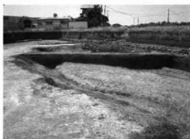
C区1号流路群セクション (東から)
