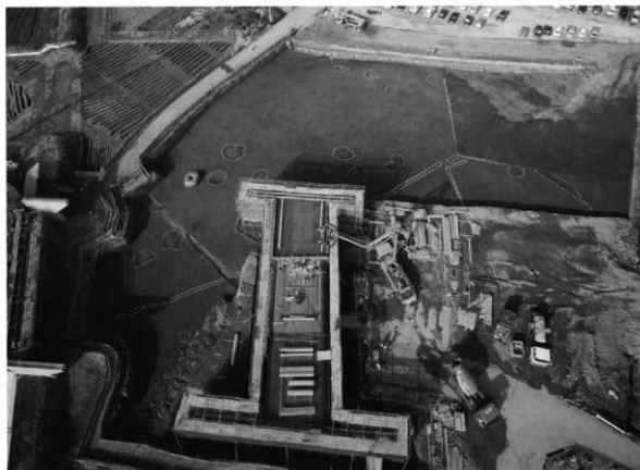
D区全景（上半部は排水調査部分、上が北）
