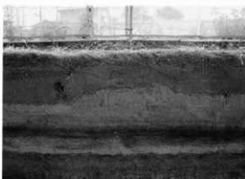
C区南壁 (第3・5面畦畔、北から)
