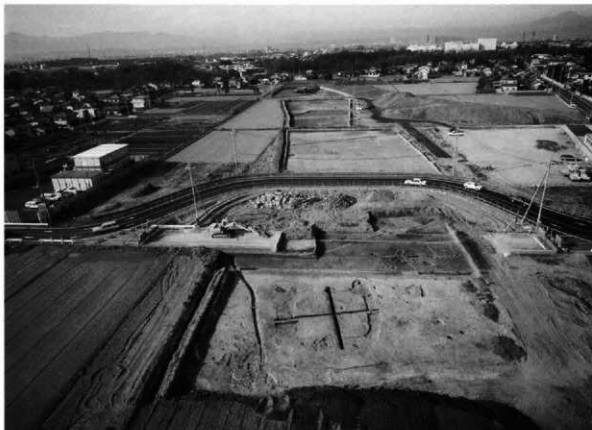
全景及び周辺の景観(東から)
