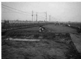
G区溝調査風景（西から）〈1〉
