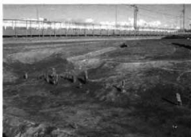
G区4号溝杭列（西から）〈1〉
