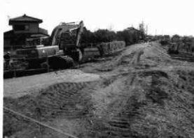
堤防除去作業（西から）
