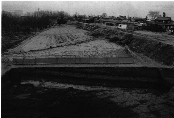
利根川左岸の土層堆積状況
