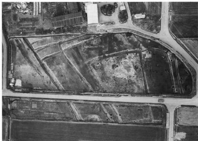
1. IV区4号館全景(南から)
