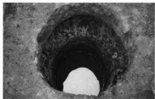
1. C区14号井戸全景 南から
