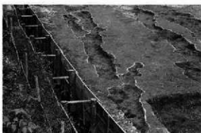
4 E5-3溝(南西より)
