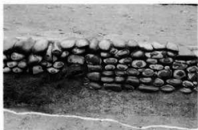
1 E1-1 溝石組西部 (南より)
