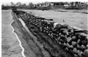
6 E1-1溝石組(南東より)
