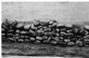
2 E1-1 溝石組東部 (南より)
