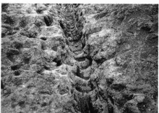
6.D区石組み溝跡痕近観（南西より）
