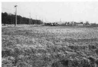
1面表土掘削（西より）
