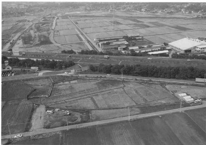
調査区遠景 (南上空より)
