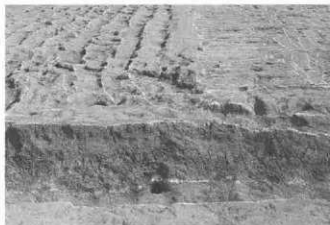
1面6号畦畔 (西より)
