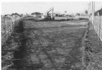
1面表土掘削（東より）
