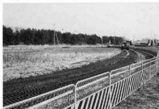
1面表土掘削（西より）
