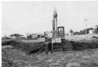
1面表土掘削（東より）
