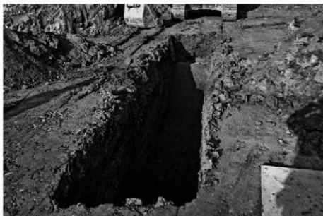
(1) Cトレンチ掘削状況(北東から)
