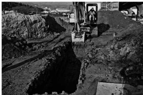
(2) 南側調査区トレンチ掘削状況 (東から)
