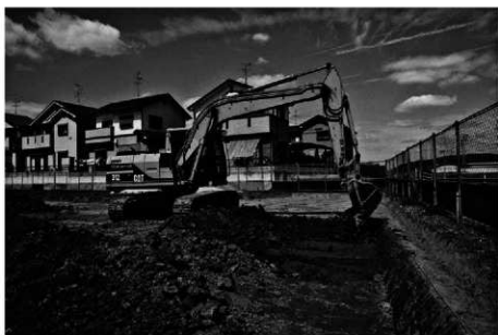
(3) A2地区重機掘削作業(南から)
