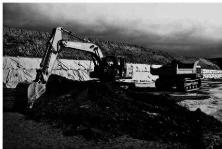
(1) 第9次重機掘削 (第2遺構面まで、北西から)
