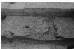
6. 同・完成状況
