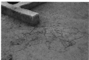
3. 土壤攪乱確認状況 (5-10・30G)
