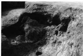
第6号地下式土坑天井崩落状況（南東から）
