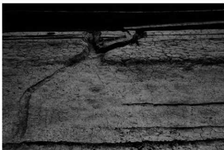
(2) D地区溝 S D349・353全景 (西から)
