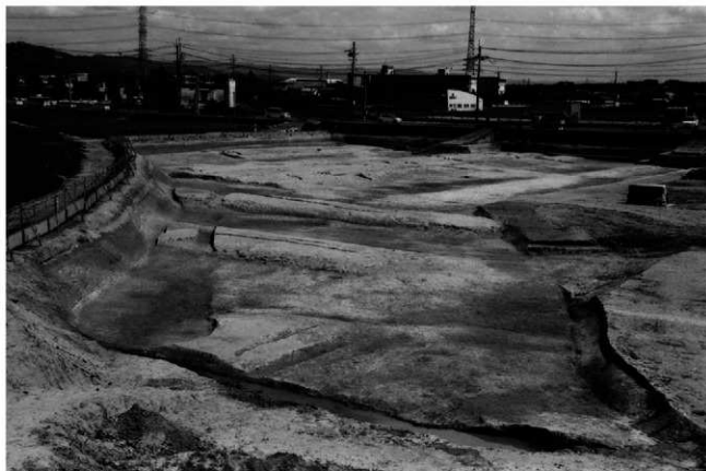
(1) D地区全景(北西から)
