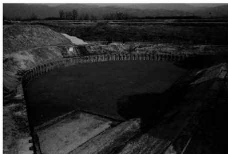
(3) 第3面全景(南西から)
