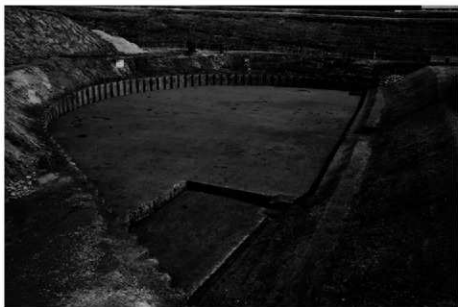
(3) 第 2 面全景 (南西から)
