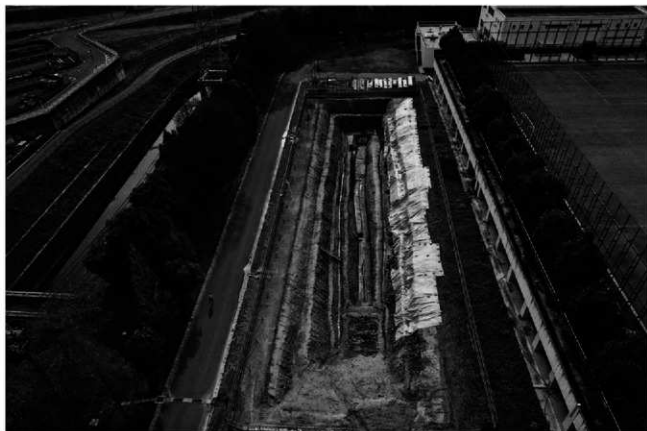
(2) 2 トレンチ全景(空撮、北から)
