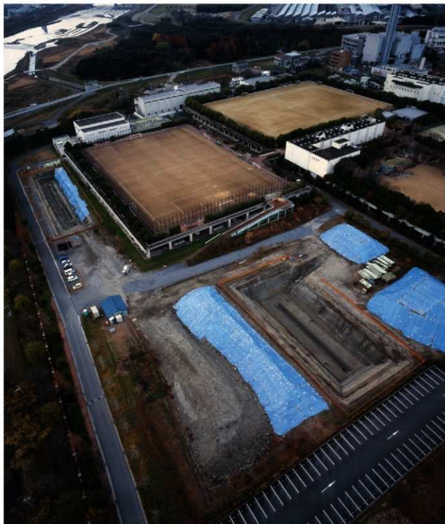
調査地全景(北東から)
