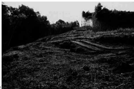
(2) A地区調査前北半部(北東から)
