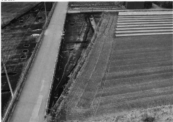
1. 15区1号道路跡全景
