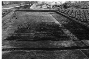
2. F区1号As-B混凝土晶跡全景
