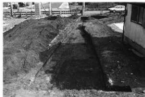
2. 2区1号柱列全景
