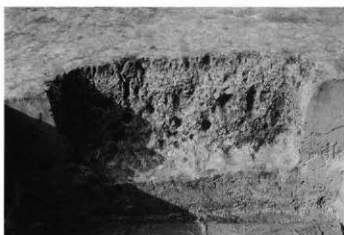
d. 同左・半割断面の状況
