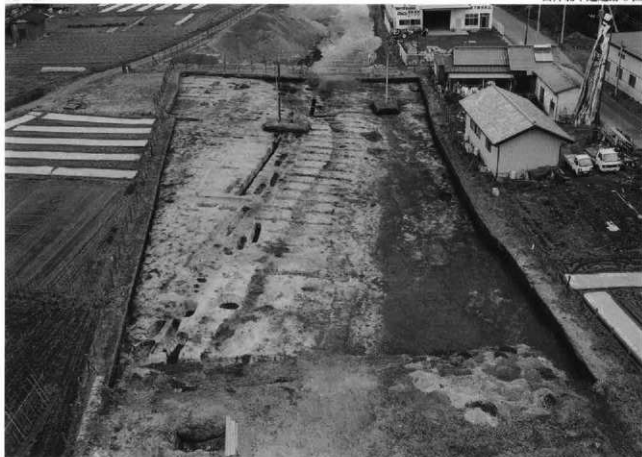
2区北半部全景 (南から)
