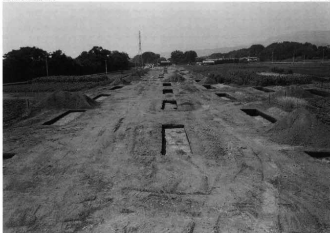
6区試掘風景（北から）
