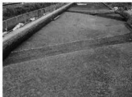
4号溝跡近景 南東→
