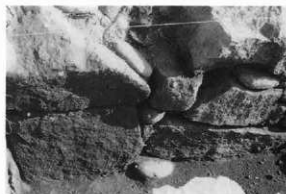
11号古墳石室東壁北半の根石 西→
