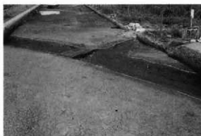
5号溝跡近景 南東→
