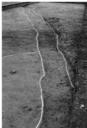
1号溝跡近景 南東→
