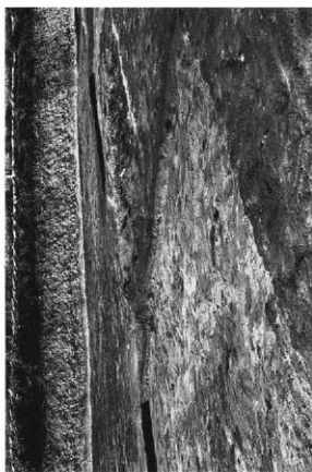
25号柱断面D (南東から)
