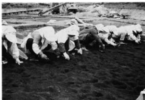
竹べら・移植ごてによるFAの除去(北中道5区)
