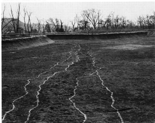
6-Iブロック全景(北から)
