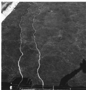
4-Dブロック全景(南から)
