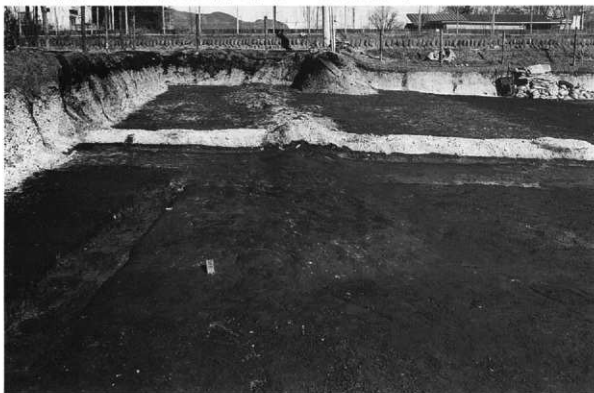
3-F・Gブロック全景（南から）
