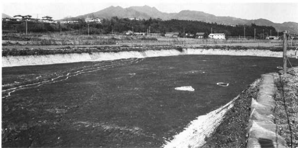
6-Gブロック全景（南から）
