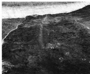
2-Bブロック全景 (白線記入後) (南から)
