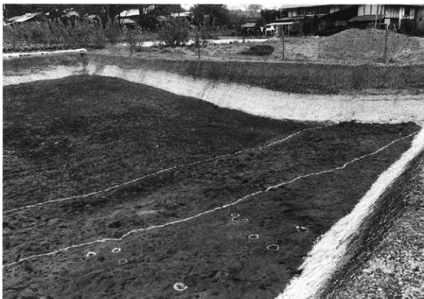
2-Eブロック全景（南東から）
