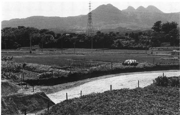
国道17号・国道303号バイパス接続部より鎌名山を望む（北東から）
